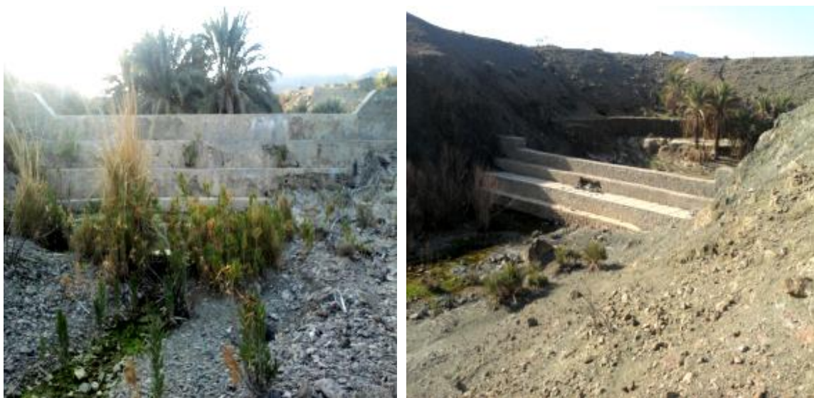
شکل ۲- نمای کلی از یک سازه آبخیزداری اجرا شده (بند اصلاحی سنگ و سیمان)
