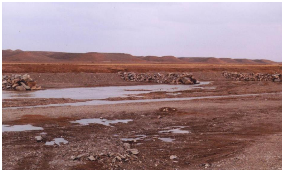
شکل ۲ - نمونه‌ای از آبشکن‌ها و خاک‌ریزهای طولی احداث شده در زنجان‌رود
