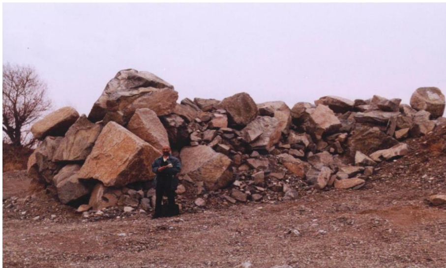
شکل ۳ - نمونه‌ای از ابعاد یک آب‌شکن احداث شده در زنجان رود به‌روش اسکله‌ریزی
