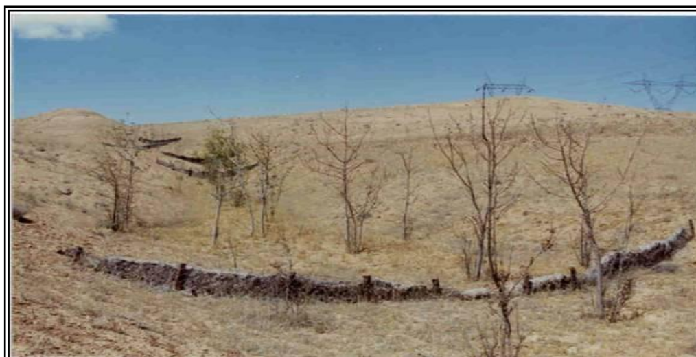
شکل ۱- نمایی از سدهای سبک فلزی احداثی در منطقه مورد مطالعه (ایده‌لو)
