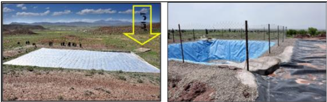
شکل ۴- مخازن ذخیره آب استحصالی: استخر با عایق ژئوممبران (سمت راست) و آب انبار (سمت چپ)
