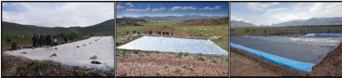
شکل ۳- پوشش عایق سامانه‌های آبیگر: ژئوممبران (سمت راست)، ایزوگام (وسط) و نایلون (سمت چپ)
