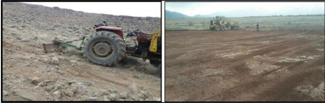
شکل ۲- تسطیح سطح سامانه عایق: ایستگاه آبخوان داری تسوج (سمت راست) و سایت پسته قیچاق (سمت چپ)
